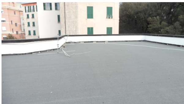
Figura 4.5 – Copertura coibentata edificio
