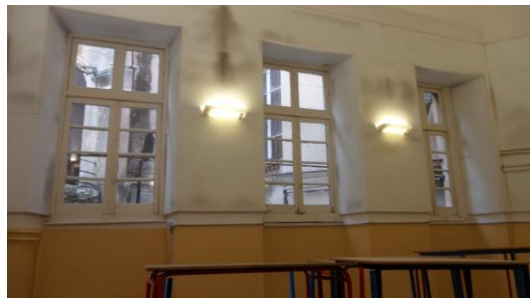
Figura 4.10 - Serramenti in legno e vetro singolo – scuola media
